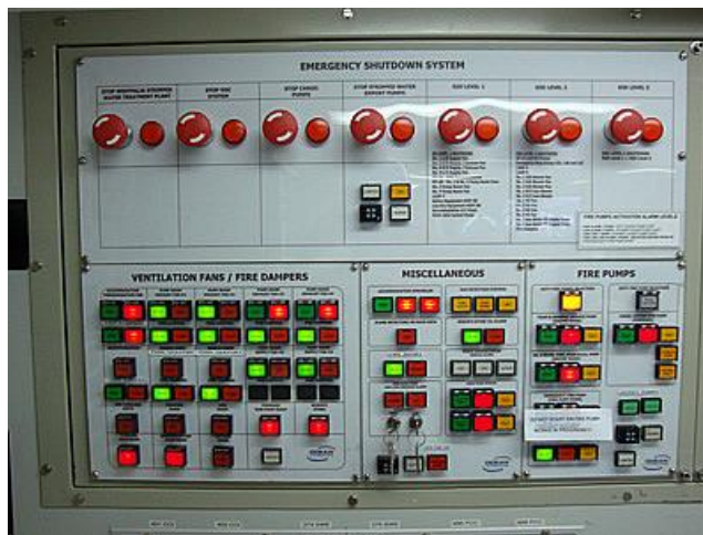
Slika 10. Mimički pokazivač koji se koristi u aplikacijama za vatru i gas. Ovaj panel prikazuje geografski raspored instalacije i opreme koji omogućava brzu vizuelnu procenu opasnosti od požara i gasa.
